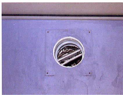
Voorbeeld 3. Goed! Bij verhitte opschuimende roosters moeten niet worden toegepast als kanaalbeëindiging van een luchtkanaal. In plaats daarvan zal een brandklep of vlinderklep moeten worden toegepast.
