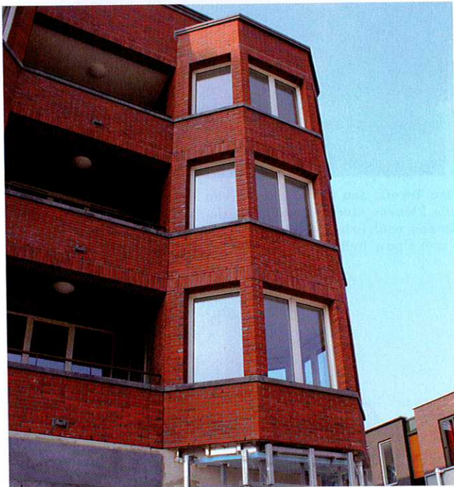
De bureaus Nöfer Architekten uit Berlijn en BBK Architekten uit Liechtenstein sluiten in hun gevelontwerp aan bij de Nederlandse baksteentraditie. Ze ontwierpen plastische gevels in een heldere oranje-rode steen met erkers en witte kozijnen. Associaties met Amsterdam en Den Haag liggen voor de hand.
