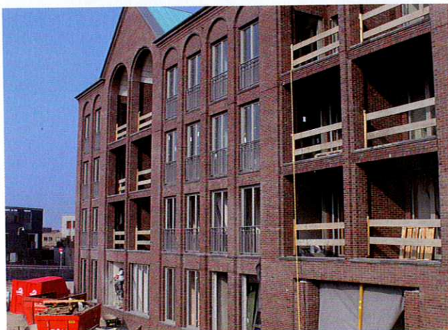
De gevels van het projectdeel van bureau Jessen+Vollenweider Architektur uit Basel hebben de uitstraling van de klassieke bouwwoorde, met penanten, timpanen en bogen. De geveldetails vragen om ambachtelijk metselwerk.
