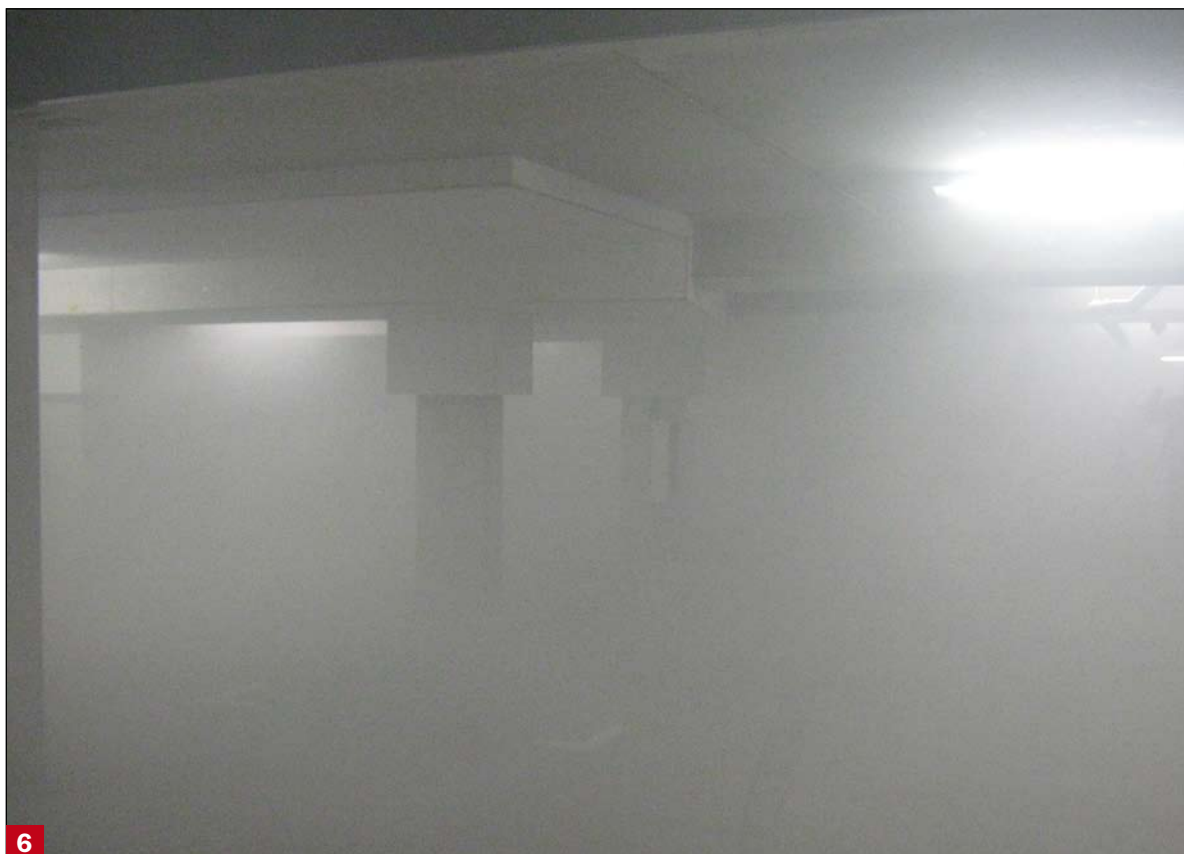
Parkeergarage met rookbelemmering, de zichtlengte voor niet-lichtgevende voorwerpen bedraagt hier gemiddeld ongeveer 5 meter
