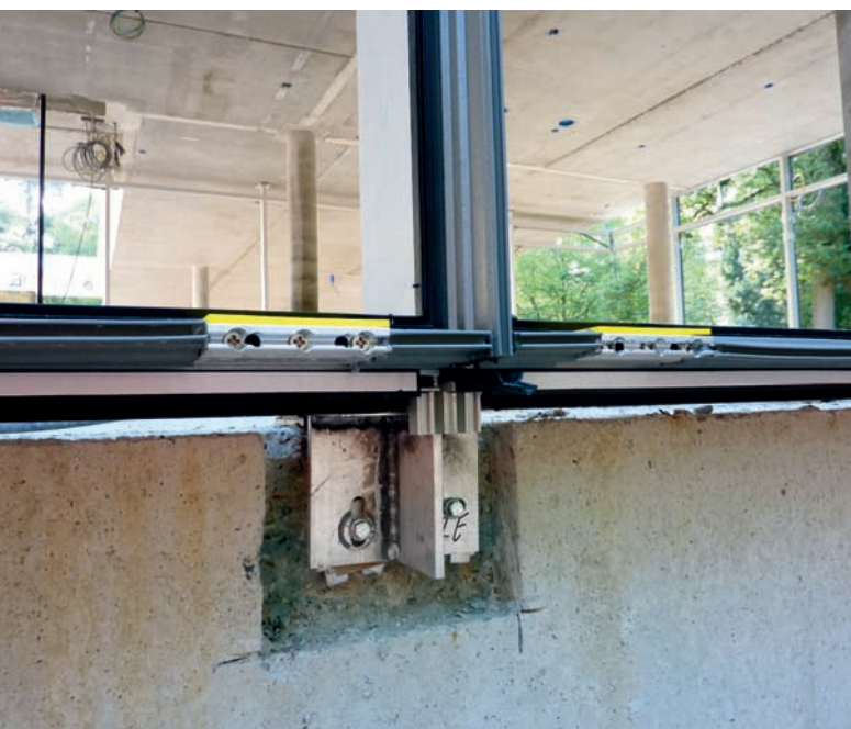
Zie het maar luchtdicht en isolerend te krijgen
