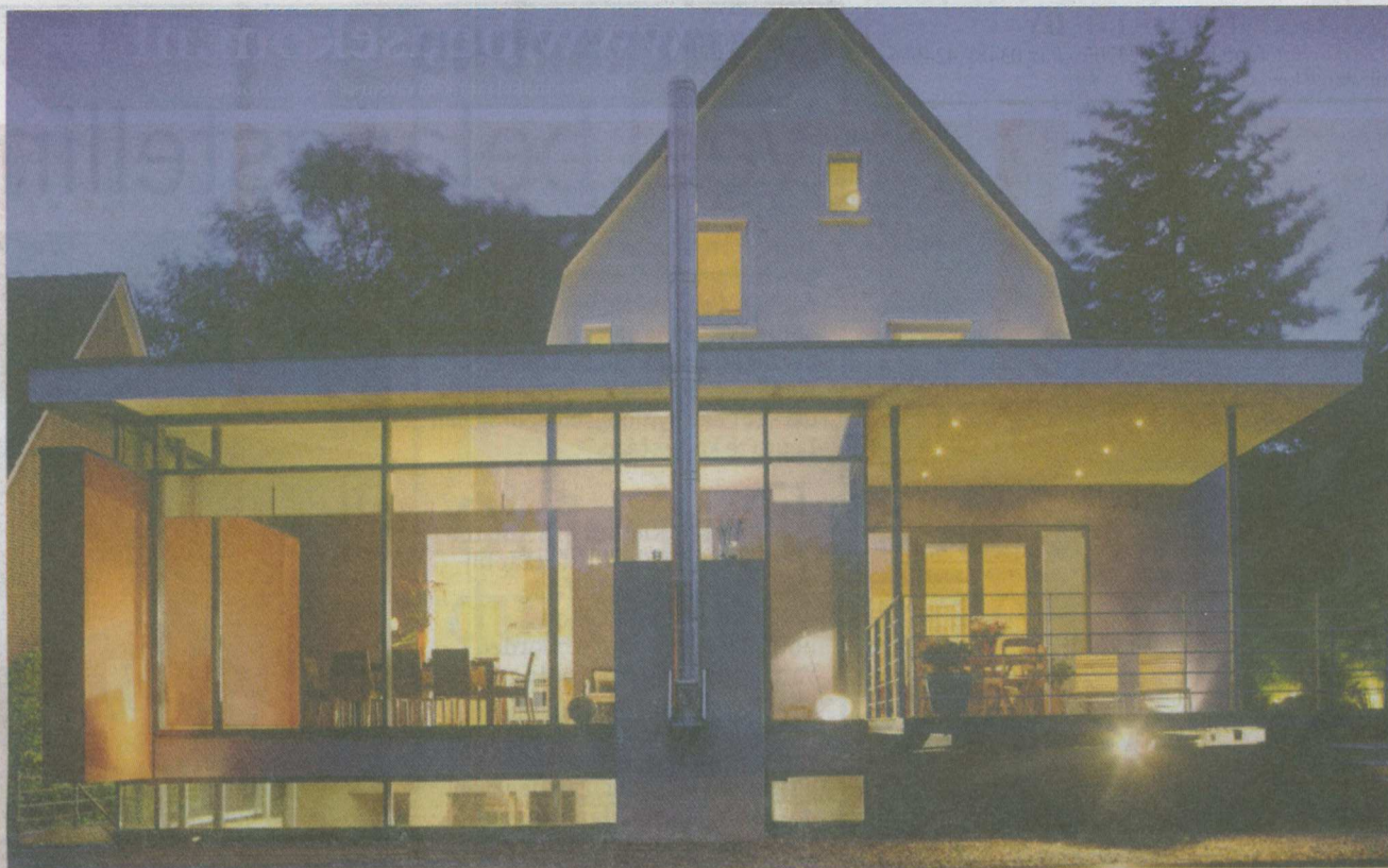
Bij de bouw van een nieuwe vrijstaande woning met een glazen uitbouw, dakkapellen en erkers moet de aannemer flink in de bus blazen om de verlaagde epc te halen. Voor een Vindex-tussenwoning of een standaard twee-onder-een-kap kan met relatief simpele maatregelen de vereiste 0,6 worden bereikt. Foto: Hollandse Hoogte/Ralf Stradtman
